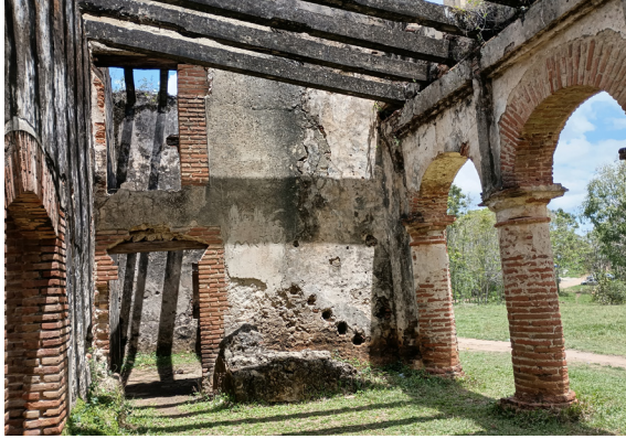
Vista interior. Detalle de columnas CASONA PALAVÉ.
