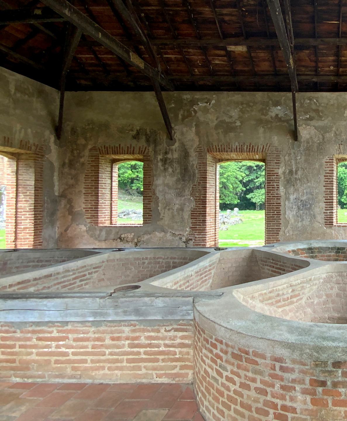
Vista interior casa de calderas INGENIO BOCA DE NIGUA.
