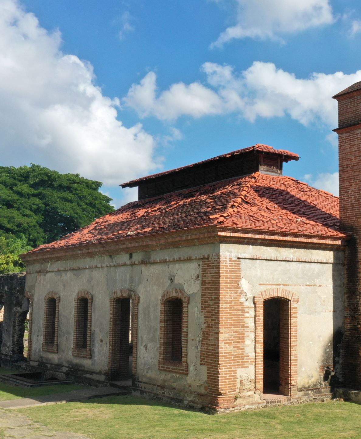
Vista lateral derecho casa de calderas INGENIO BOCA DE NIGUA.
