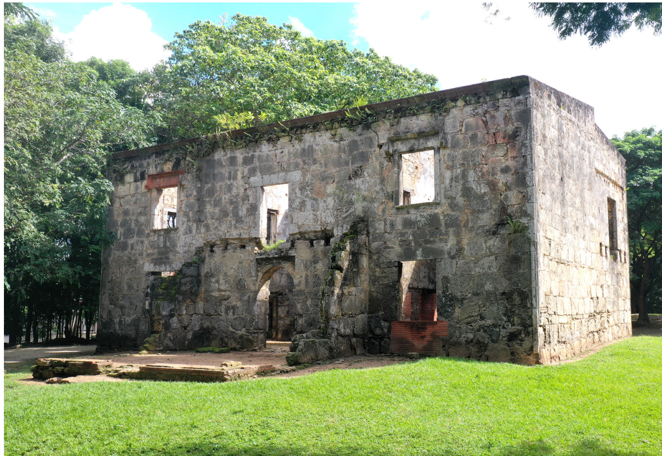
Vista fachada frontal casona INGENIO SANTA ANA DE ENGOMBE.
