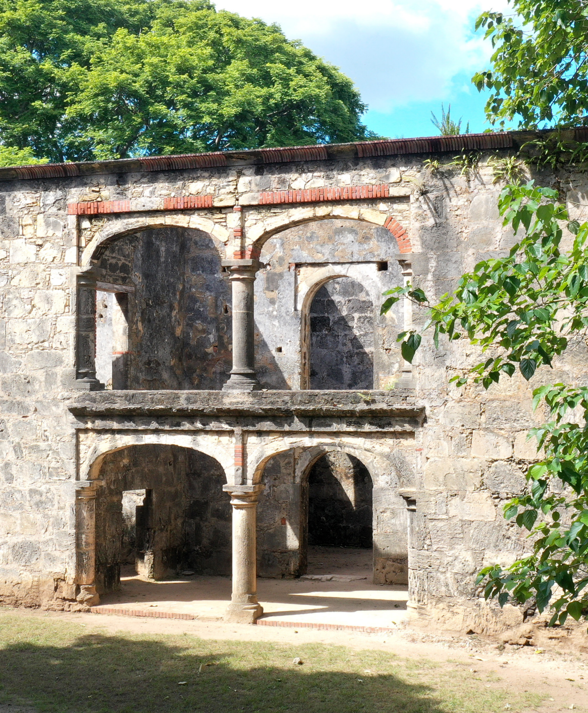
Detalle de arcadas fachada posterior de la casona INGENIO SANTA ANA DE ENGOMBE.
