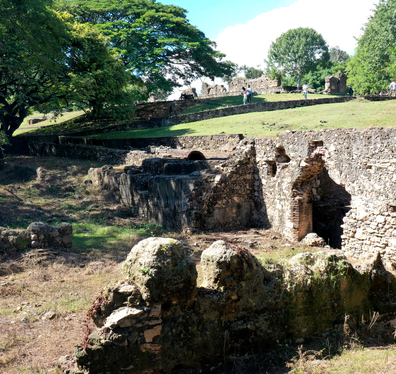
Vista interior casa de molienda INGENIO DIEGO CABALLERO.
