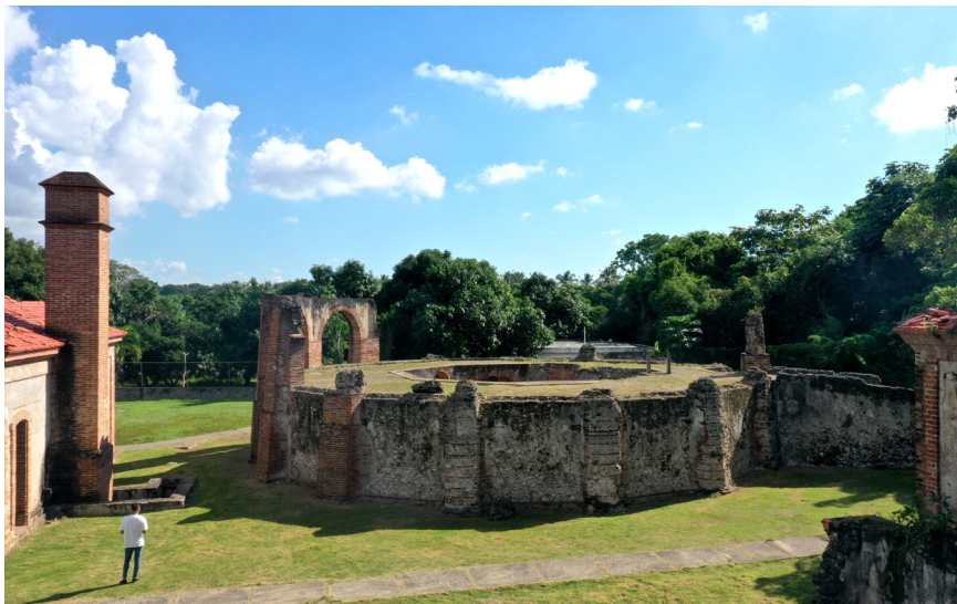
Vista lateral INGENIO BOCA DE NIGUA.
