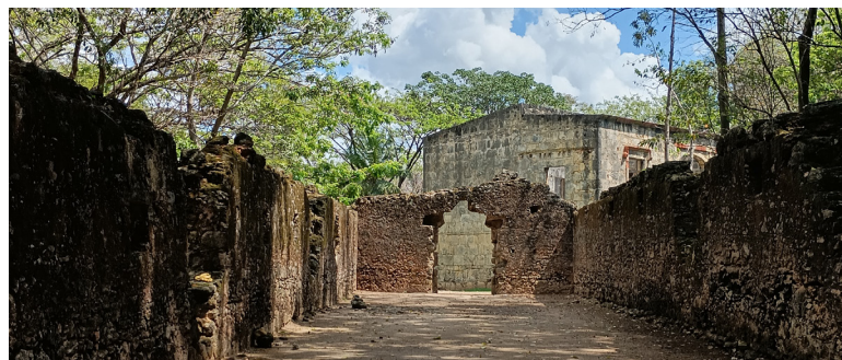
Vista interior almacén INGENIO SANTA ANA DE ENGOMBE.
