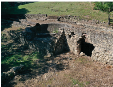
Vista interior casa de molienda INGENIO DIEGO CABALLERO.
